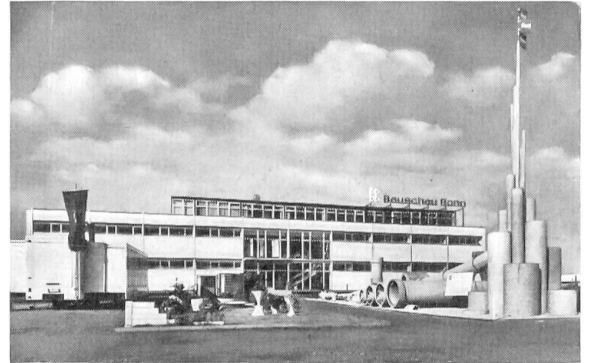
Die Bauschau Bonn, an der Adenauerallee gelegen, mit einer großen Sonderabteilung über den baulichen Zivilschutz.
