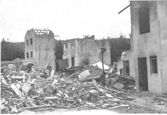
Trümmerdorf der Bundesschule des Luftschutz-Hilfsdienstes im Ahrtal.
