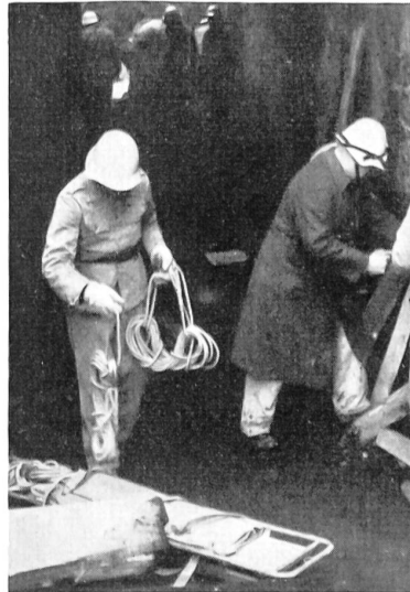
Hinter der mit Hammer und Spitzhacke arbeitenden Gruppe werden bereits die Rettungsbretter und Sicherungsseile bereitgemacht, die dann den durch die geschlagene Öffnung steigenden Rettern mitgegeben werden.
