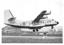
Ein großer Wurf der französischen Breguet-Werke: der Kampfzonen-Transporter Breguet 941 S. Bei einem Startgewicht von 20 Tonnen hebt die Maschine nach einer Rollstrecke von nur 150 Metern(!) vom Boden ab. Die französische Luftwaffe hat bereits eine .... schinen in Auftrag gegeben. Photo Hauber waffe hat bereits eine Anzahl dieser Ma-
