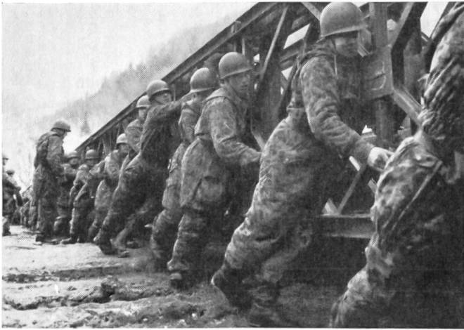
Vorschieben einer D-Brücke
