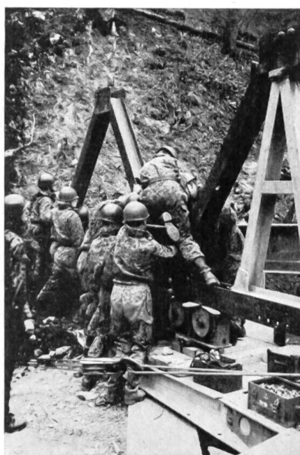
Zusammensetzen der D-Brücken-Elemente
