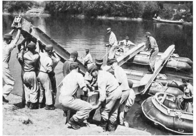
Bau einer leichten Uebersetzfähre aus Alu-Brückengerät
