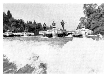
Auf eine weite Flußstrecke verteilt, wurden die verschiedenen Brückenglieder «aufgerüstet». Die zu größeren Einheiten zusammengefügten Schiffe — hier Zweiteiler — müssen in der starken Strömung mit äußerster Präzision an die vorbereitete Brückenbau-Stelle gefahren werden.
