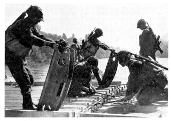
Die voneinander unabhängigen Glieder einer Schlauchbootbrücke werden zu größeren Einheiten zusammengekoppelt und diese wiederum in einem genau einstudierten und oft geübten Taktverfahren zusammengefügt.
