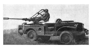
Eskortefahrzeug. Leichter Geländelastwagen mit aufmontiertem 20-mm-Flab-Geschütz.
