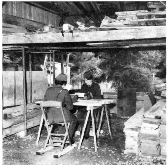
Eine improvisierte Kanzlei im Walde, von FHD des administrativen Dienstes eingerichtet, ist betriebsbereit.
