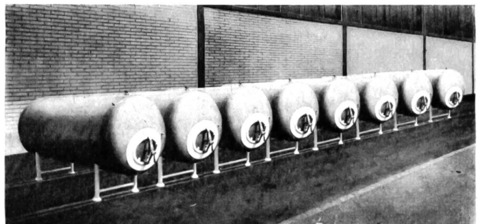
Trinkwassertanks aus glasfaserarmiertem Kunstharz
