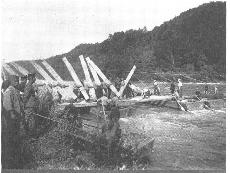
Genietruppen beim Brückenbau
