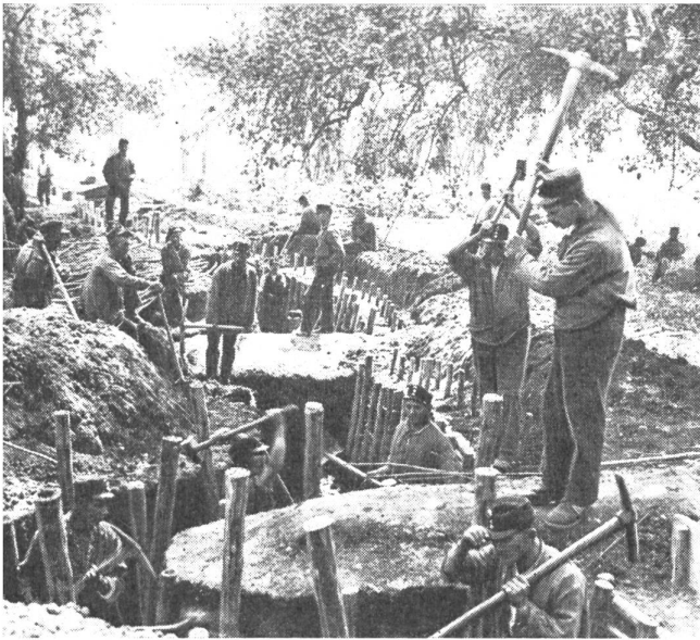
Schützengrabenarbeiten der Fortifikation Hauenstein. Das ganze Hauensteingebiet wurde stark befestigt als Abwehrstellung gegen Norden und Nordwesten und zum Schutz des wichtigen Eisenbahnknotenpunktes Olten
