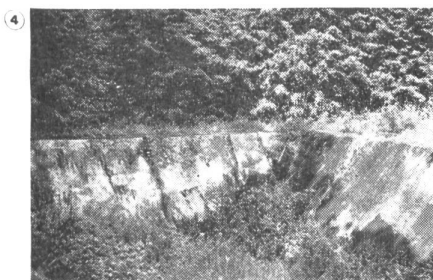
Nahe bei Hitlers Bunker ein Bassin für Löschwasser.
