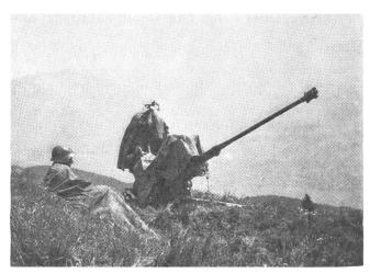
20 mm Fliegerabwehrkanone Modell 1954 Einsatz gegen Flugzeuge sowie gegen leicht gepanzerte Fahrzeuge bis 1500 m Entfernung. Trommelmagazin. Schußfolge 1000/Min.
