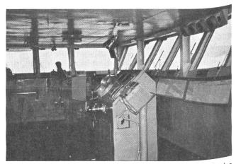
Blick in den Raum der Kapitänsbrücke. Im Vordergrund ist das kleine Steuerrad an dem Pult sichtbar. Mit diesem winzigen Rad wird das mächtige Schiff gesteuert. Im Hintergrund ist der erhöhte Sitz des Kapitäns erkennbar. Von dort aus leitet dieser hohe Offizier die Operationen des Schiffes, wobei er eine vollständige Uebersicht über das Flugdeck genießt.
