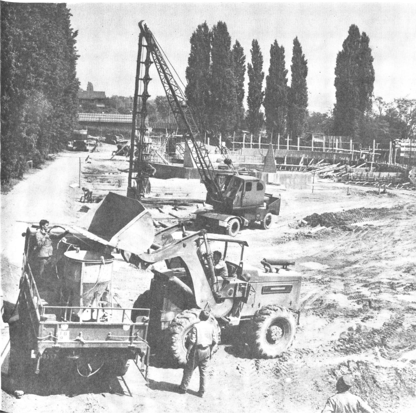
Bild 3 Bauplatz «Wehrhafte Schweiz». Im Vordergrund Pneu- ladeschaufel bei Verladearbeiten. Kranwagen bei Pfählungsar- beiten. Im Hintergrund die Fundamente des «Ige's».
