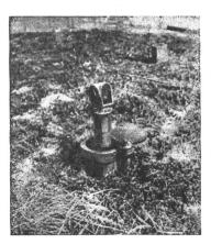
Bunkerdach. Abschließbare Oeffnung zum Ausfahren eines Rundblick-Periskops.
