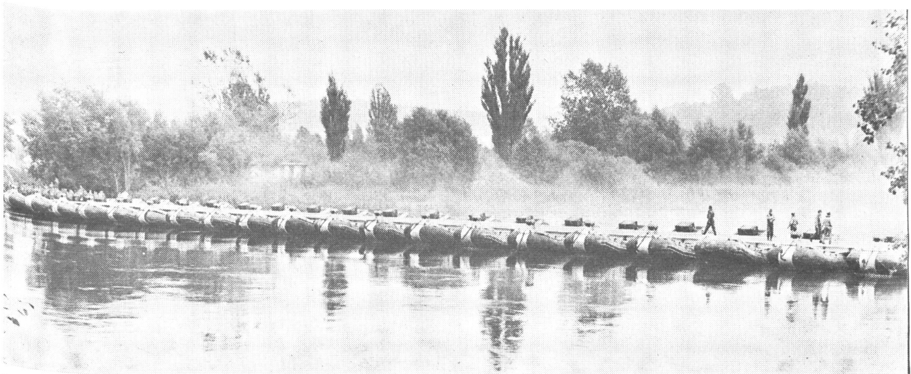
Die fertige 50-Tonnen-Schlauchboot-Brücke
