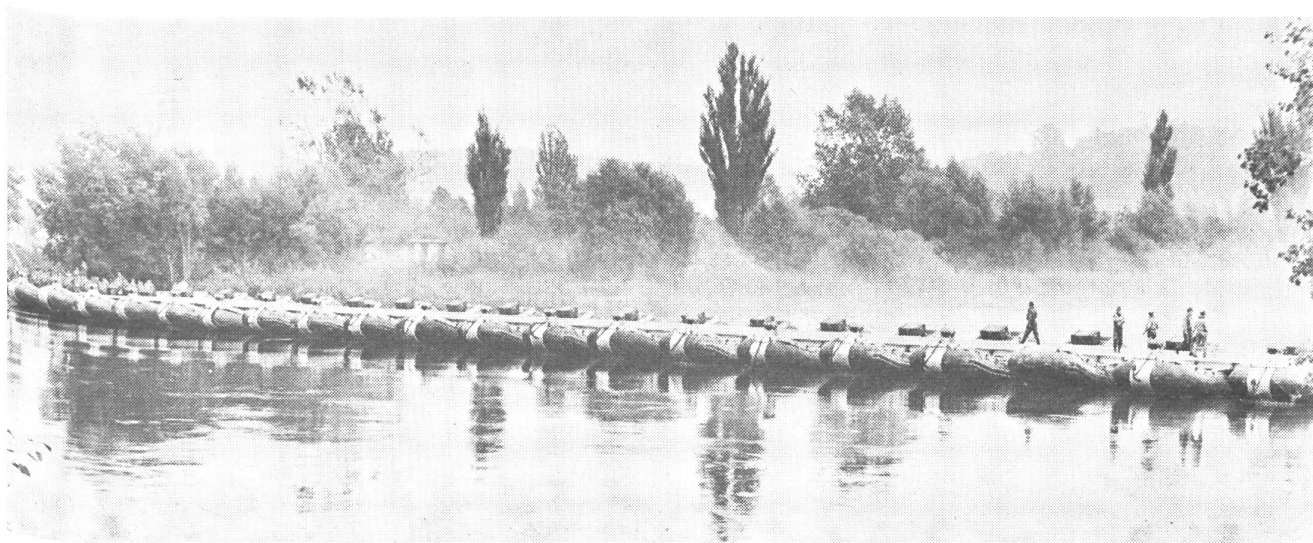
Die fertige 50-Tonnen-Schlauchboot-Brücke
