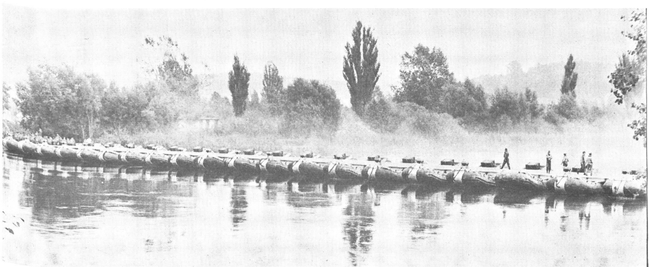
Die fertige 50-Tonnen-Schlauchboot-Brücke
