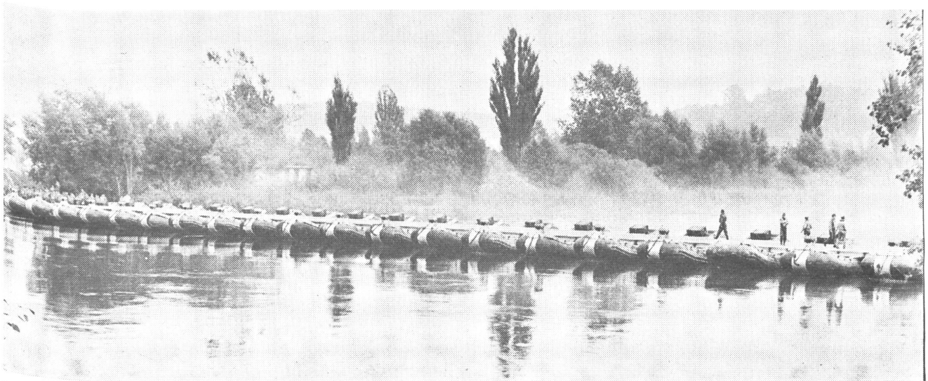
Die fertige 50-Tonnen-Schlauchboot-Brücke
