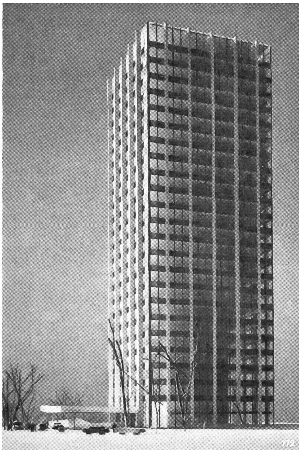
Das im Bau begriffene Sulzer Büro-Hochhaus
