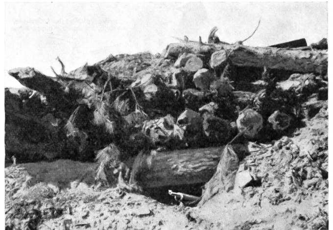
Überdeckte Waffenstellung nach dem Beschuß! Beachte die Wirkung des Vorbereitungsfeuers. Rundholz der Überdeckung verschoben und durcheinandergeworfen. Scharte durch Erde teilweise verschüttet.
