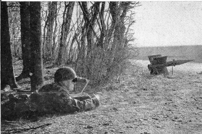
Die MOSQUITO wird ohne Abschussgestell direkt vom Boden gestartet, und der Schütze lenkt sie mittels eines Lenkknüppels über elektrische Signaldrähte ins Ziel. Für Übungsschiessen wird der Kriegskopf durch einen Übungs-Fallschirmkopf ersetzt, womit die Rakete nach erfolgtem Fluge zurückgewonnen werden kann.
