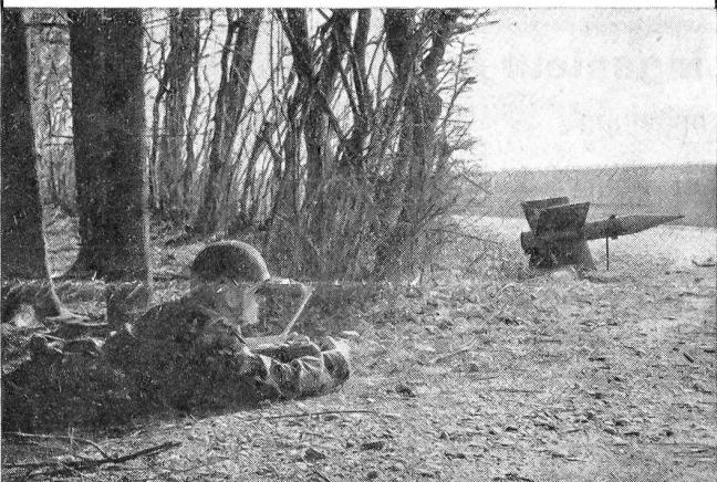
Die MOSQUITO wird ohne Abschussgestell direkt vom Boden gestartet, und der Schütze lenkt sie mittels eines Lenkknüppels über elektrische Signaldrähte ins Ziel. Für Übungsschüsse wird der Kriegskopf durch einen Übungs-Fallschirmkopf ersetzt, womit die Rakete nach erfolgtem Fluge zurückgewonnen werden kann.
