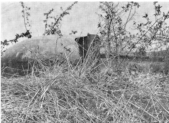
Getarnte Panzerkuppel im Vorfeld der Bunker
