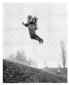
Der amerikanische Ingenieur Harold Graham, von der Firma Bell Aerosystems Company, hat mit dem Versuchsmodell eines Raketengürtels viele erfolgreiche Versuche unternommen, die ihn zum ersten «fliegenden Menschen» werden ließen. Der Raketengürtel besteht aus einem Behälter mit Wasserstoffsuperoxyd, das beim Kontakt mit einem gasförmigen Katalysator aus zwei Oeffnungen entweicht und dadurch den Träger des Gürtels mühelos in die Höhe hebt.
