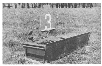
Neue Aussichten für eine kriegsgenügende Gefechtsausbildung eröffnet diese in Erprobung befindliche Scheibenanlage «Zschokke», die überall im Gelände eingebaut werden kann. Ein System von 32 solcher Scheiben kann vom Übungsleiter mit Funk gesteuert werden; er kann die Scheiben, die bei jedem Treffer automatisch verschwinden, einzeln oder in Gruppen überraschend auftauchen oder sich entfernen lassen.
