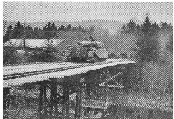
Von Genietruppen gebaute feste Brücke.
