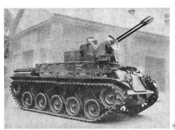
**Selbstfahr-Flab. 25 t, M-42,** 40-mm-Flab.-Zwillingsgeschütz mit Radarentfernungsmessung und Feuerleitsystem T-50, Drehturm oben offen, 5 Mann, mobiler Flabschutz der US-Divisionen.
