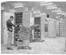
Das Gehirn der Radaranlagen sind unzählige Schaltapparate, Drehknöpfe und für den Laien unübersehbare Draht- und Kabelverlegungen, die die General Electric ausgeführt und montiert hat.
