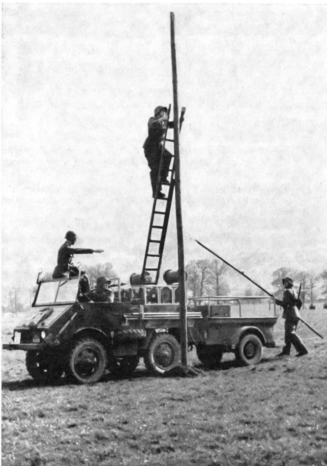
Demonstration des motorisierten Leitungsbaues anlässlich des Tages der Übermittlungstruppen in Luzern.
