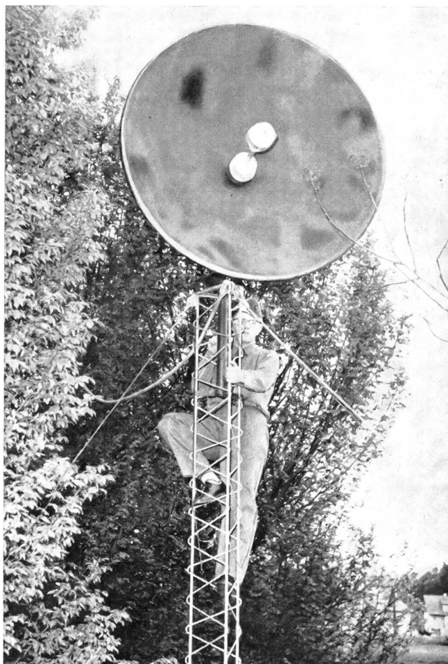
Aufbau einer Richtstrahlantenne
