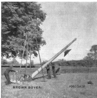
■ Aufbau des Antennenmastes
