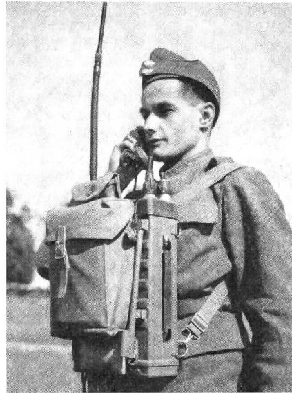
Die Schweizer Armee wird mit einem frequenzmodulierenden Kleinfunkgerät SE 206—209 ausgerüstet, das als Verbindungsmittel auf kürzere Distanzen (5 bis 20 Kilometer) sämtlichen Waffengattungen gute Dienste leisten wird. Das 11,3 Kilo schwere Gerät ist tragbar und kann mit einem Zusatzergerät als stationäre Anlage auf einem Jeep verwendet werden.
