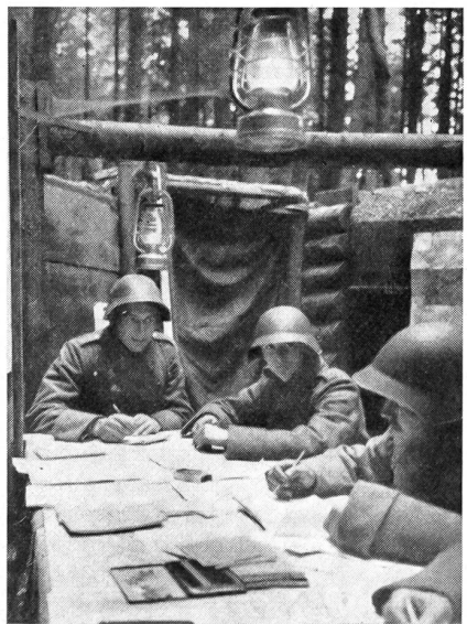
Kaum ist der Kommandoposten eingegraben, hat auch schon die Nachrichtenequipe die Arbeit aufgenommen. Sappeure erstellen erst noch das schützende Dach.
