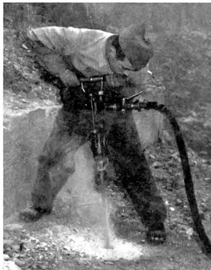
Mit dem Preßlufthammer werden rasch die Löcher für Sprengungen gebohrt.
