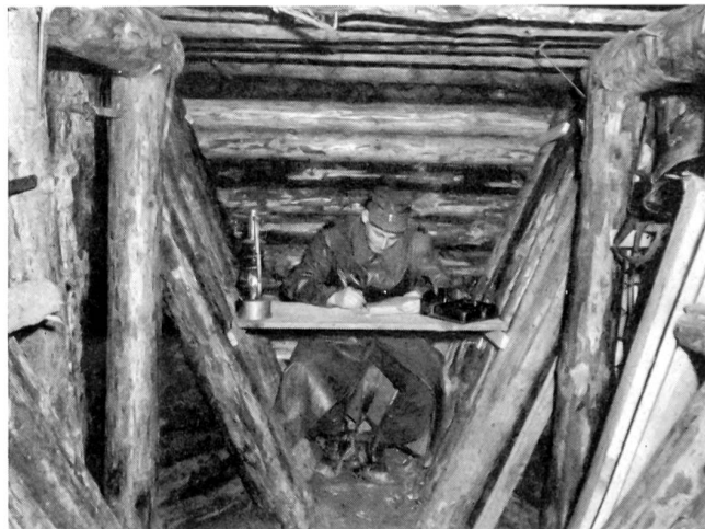
Primitiver, aber rasch erstellter Holzunterstand.
