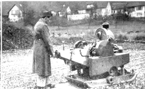
Bodenverrichter für den Schnellstraßenbau.
