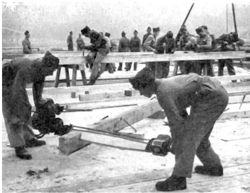
Holzbearbeitung mit Benzinkettensäge. Kiesgewinnung für den Straßenbau mit Kranwagen als Bagger in der Aare.
