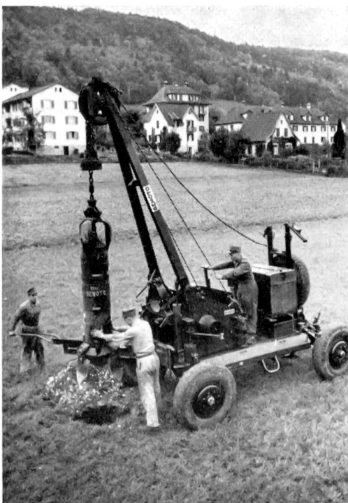
Erdbohrgerät im Einsatz.
