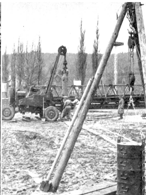
Arbeit mit dem Erdbohrgerät.
