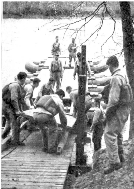
Bau eines Schlauchbootsteiges.
