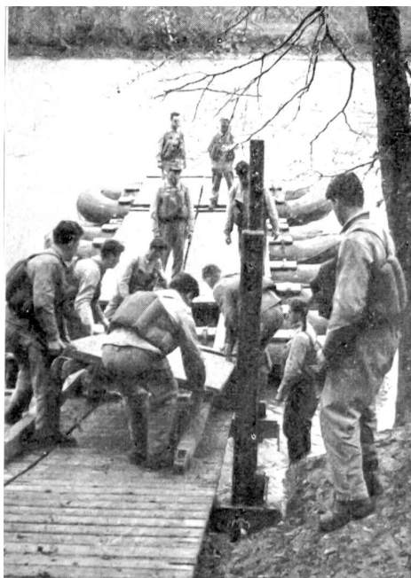
Bau eines Schlauchbootsteges.
