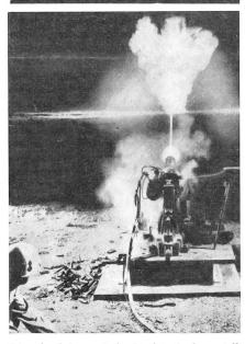
Diese hochdramatische Nachtaufnahme stellt der Oeffentlichkeit erstmals ein neues amerikanisches überschweres Maschinengewehr vor, welches aus sechs Läufen pro Minute eine Tonne Munition verpulvert. Das Mg hat eine Bohrung von 20 mm und ist hauptsächlich zum Einbau in Kampfflugzeuge vorgesehen. Das Schnellfeuergewehr hat den Namen «Vulcan» erhalten, einen Namen, der sich durchaus zu rechtfertigen scheint. ATP
