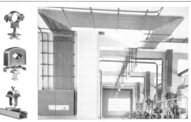
Woertz-Profilschienen No 4382/4383 aus Stahl oder Anticorodal und Zubehörteile ermöglichen rasche und übersichtliche Verlegung von Rohr- und Kabelsträngen. Die gleichen Profilschienen mit entsprechenden Verbindungs-Stücken dienen auch zum Bau von Schalttafeln und Verteilgestellen.
