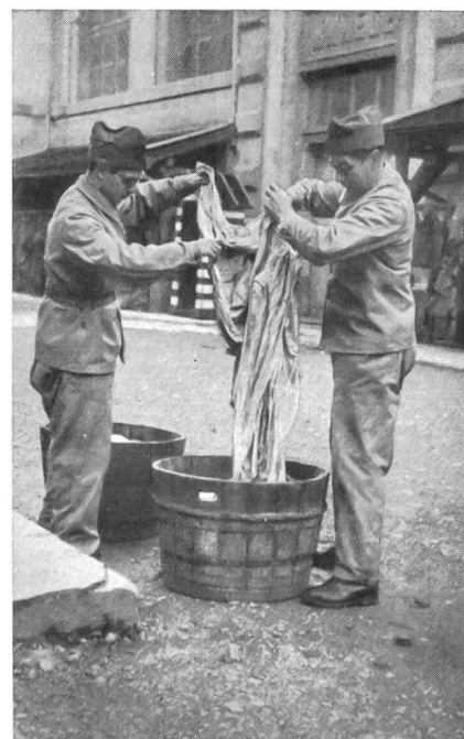
Nach Gebrauch in verseuchtem Gebiet müssen die Yperitschutzkleider sorgfältig entgiftet werden.
