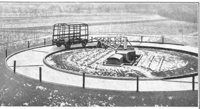
Lenksystem eines Anhängers wird auf werkeigener Versuchsbahn erprobt
