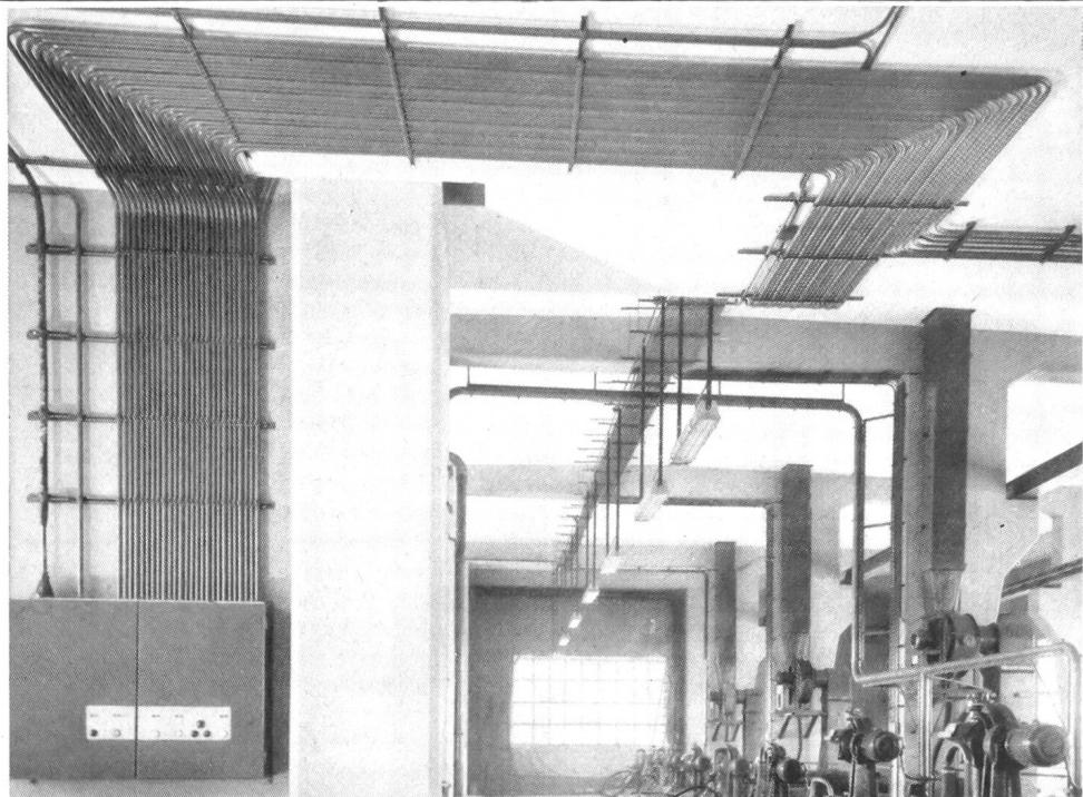
**Woertz-Profileschienen № 4382 / 4383** aus Stahl oder Anticorodal und Zubehörteile ermöglichen rasche und übersichtliche Verlegung von Rohr- und Kabelsträngen. Die gleichen Profileschienen mit entsprechenden Verbindungs-Stücken dienen auch zum Bau von Schalttafeln und Verteilgestellen.
