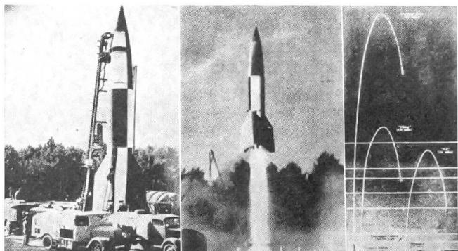
Die Luftabwehr konnte den geradeaus fliegenden «Lufttorpedo» leicht abschießen, und für Jagdmaschinen wurde er eine leichte Beute. Dagegen war die V 2 schwer, wenn nicht gar unmöglich zu bekämpfen. Die V 2 bestand aus einem geschossähnlichen Körper von nahezu 15 Meter Höhe. Man erhält einen achtunggebietenden Eindruck von ihrer Größe, wenn man sie mit den Menschen und Autos daneben vergleicht.
