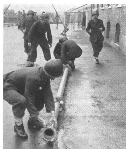
Die Feuerwehrzüge der Zivilverteidigungskolonnen verfügen über eine bemerkenswerte Ausstattung von Schnellkupplungsrohren, von denen in knapp 7 Minuten 420 Meter verlegt und an das Wasser angeschlossen werden können. Trümmerhaufen und andere Hindernisse können durch Ueberleitungen (siehe Tor im Hintergrund) rasch überbrückt werden.
