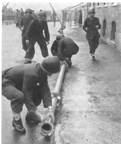
Die Feuerwehrtzüge der Zivilverteidigungskolonnen verfügen über eine bemerkenswerte Ausrüstung von Schnellkupplungsrohren, von denen in knapp 7 Minuten 420 Meter verlegt und an das Wasser angeschlossen werden können. Trümmerhaufen und andere Hindernisse können durch Ueberleitungen (siehe Tor im Hintergrund) rasch überbrückt werden.
