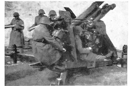
Höhen- und Seitenrichter beim angestrengten Verfolgen der Zeiger während des Schießens.
