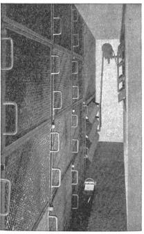
Filterbatterie und automatische Klappen
