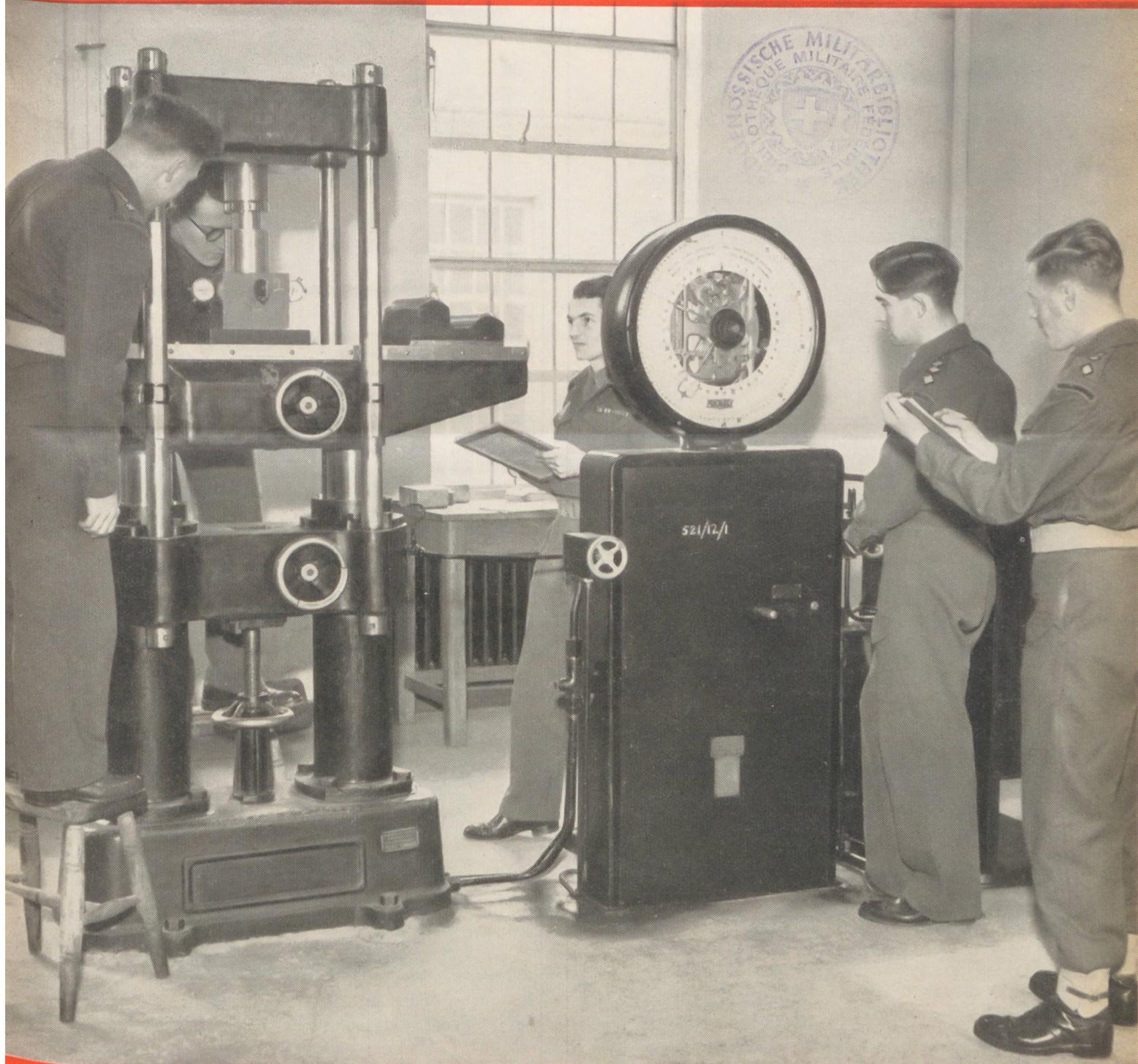
Unser Titelbild: Ausbildung der britischen Armee: Eine kleine, aber vorzüglich eingerichtete Materialprüfungsanstalt ist dem Institut angegliedert. Die Armee sendet hierher Metalle und Metall-Legierungen, die sie braucht. Maschinen, die Drucke bis auf 100 Tonnen ausüben, zermärtern diese Muster.
