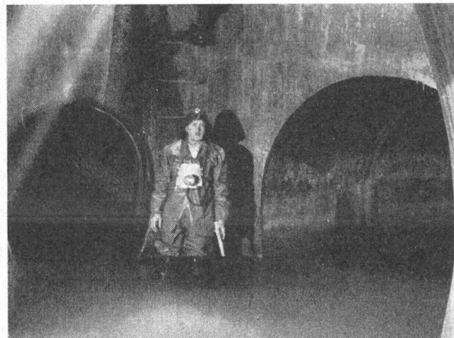
b) Stollen mit Ei-Profil (Ausmaße von 60/90 cm bis 120/180 cm);
