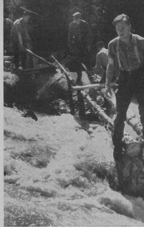
Ueber die reißende Flut der entfesselten Lutschine wurden von Stein zu Stein Stämme und Uebergänge gelegt. Sie dienten der Verankerung der Verdämmungen und dem Transport des Kompressorenkabels der Bohrhämmer, mit denen die Sprengung einzelner, die Wasser ablenkender Felsen vorbereitet wurde.
