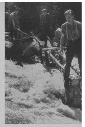
Ueber die reißende Flut der entfesselten Lütschine wurden von Stein zu Stein Stämme und Uebergänge gelegt. Sie dienten der Verankerung der Verdämmungen und dem Transport des Kompressorenkabels der Bohrhämmer, mit denen die Sprengung einzelner, die Wasser ablenkender Felsen vorbereitet wurde.
