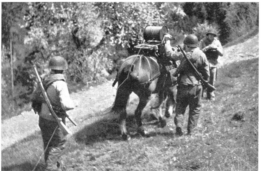
Das verlegte Kabel wird wieder eingezogen.
