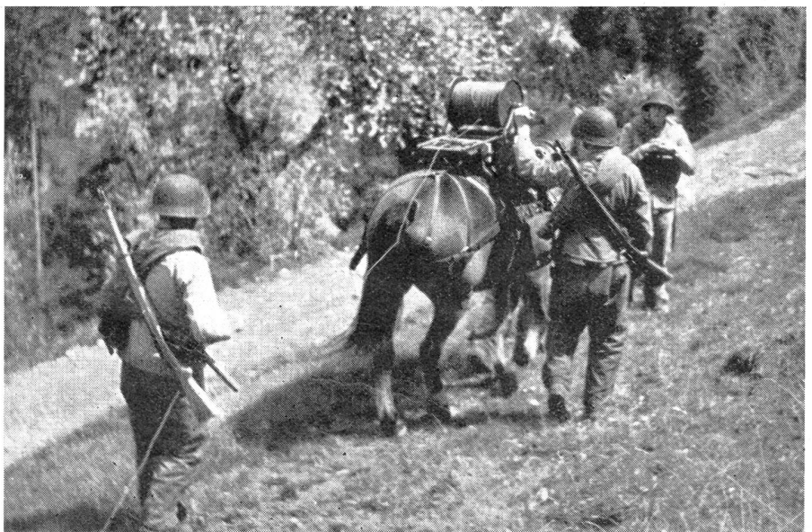
Das verlegte Kabel wird wieder eingezogen.
