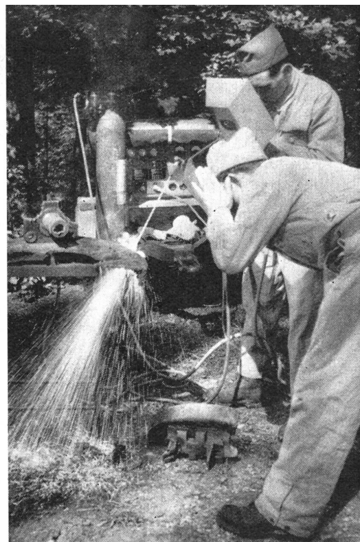
Die Elektroschweißanlage wird auf einem Anhänger des Werkstattwagens mitgeführt.
