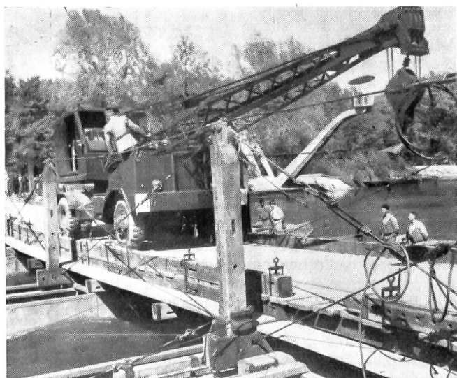
Schwerer Bagger passiert eine Pontonbrücke. (Photopress Zürich)
