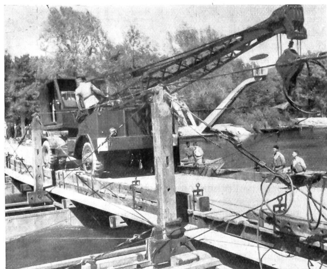
Schwerer Bagger passiert eine Pontonbrücke. (Photopress Zürich)
