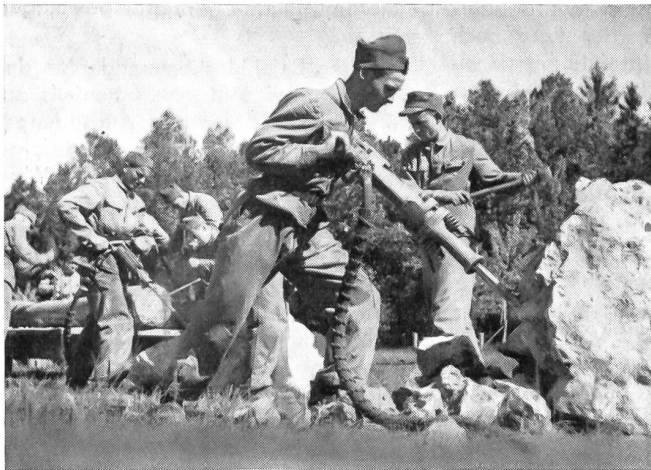
Sappeure mit Preßluftbohrern bei Schuttwegräumung. (Photopress)
